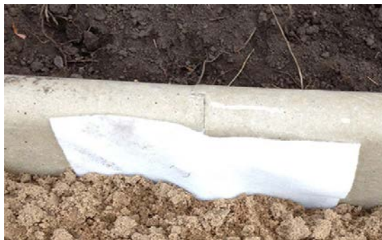
Geotextilie na zadní straně zábrany
